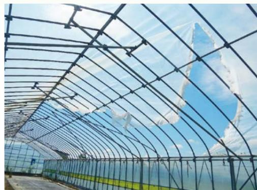
強風により被覆材が大きく破れたハウス
